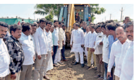
కంకల్,లాల్‌పహాడ్ బిటిరోడ్డు నిర్మాణపు పనులను పరిశీలిస్తున్న ఎమ్మెల్యే రామ్మోహనరెడ్డి,తదితరులు
